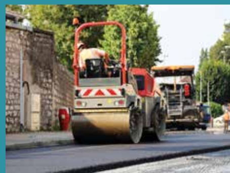
● Travaux de voirie boulevard Wilson.
