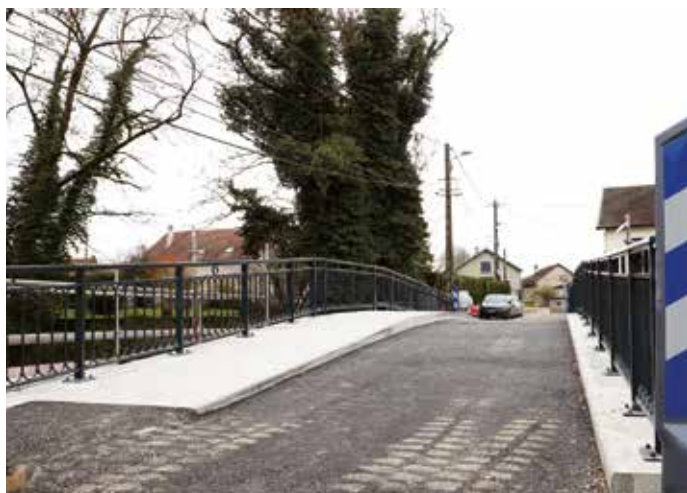
● Le pont est désormais franchissable.
