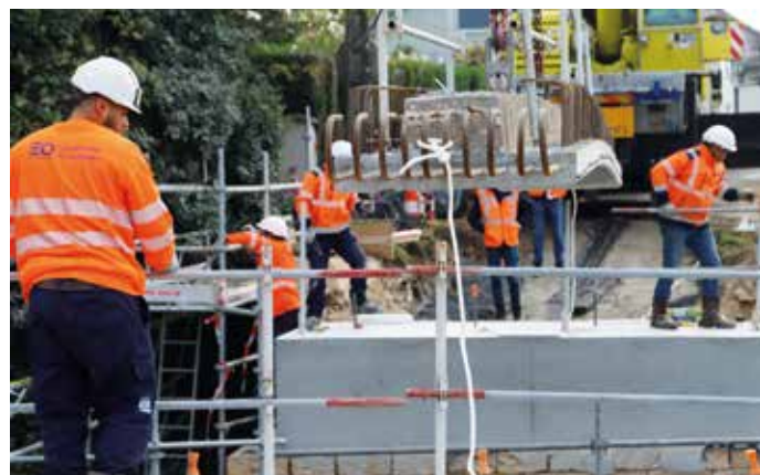
● Crutage des poutres du pont à la mi-novembre.
